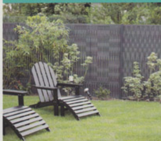
Cette clôture Dirickx de fabrication française a été installée sans outil avec des lamelles de PVC.
